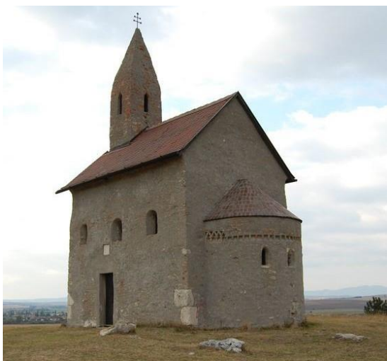
Obr. 06: Kostol v Nitre-Dražovciach – novšia stavba na základoch staršej. Zdroj: https://apsida.sk/c/7/drazovce
