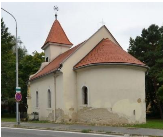
Obr. 05: Kostol v Nitre-Párovciach – novšia stavba na základoch staršej. Zdroj: https://apsida.sk/c/2511/nitra-parovce
