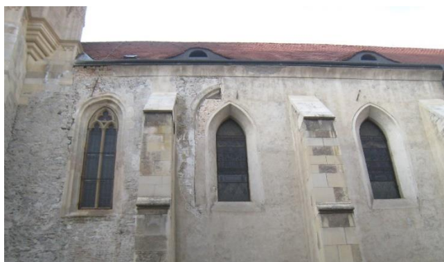
Obr. 27: Bývalý kostol klarisiek v Bratislave. Nahradenie gotických okien renesančnými. Gotické okno ponechané v 1. poli. V 2. poli sonda odkryla časť gotického okna zmenšeného v renesancii. Foto: Andrej Botek
