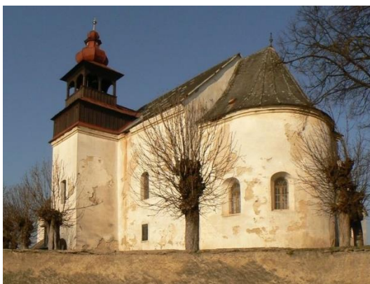
Obr. 24: Rotunda v Kameňanoch začlenená do prístavby ako apsida. Zdroj: https://apsida.sk/c/3192/kamenany
